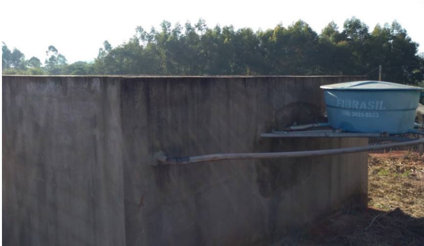
Foto 2 – Vista do Reator Anaeróbio UASB
